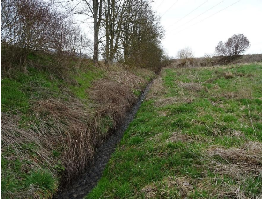
Foto 9 Blick nach Osten über den befestigten Klosterbach
