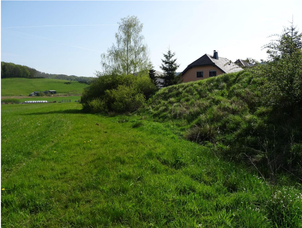
Foto 3 Blick nach Nordosten über den Graben (Mai 2024)
