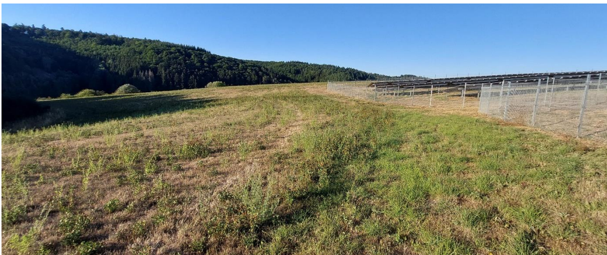
Abbildung 8: Versickerungsanlage im Bereich des Bebauungsplanes „In Repperstal“
